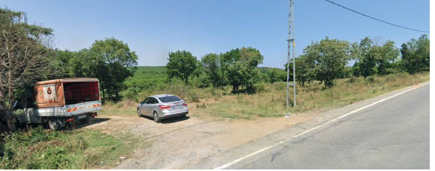
Aynı noktanın Temmuz 2019 tarihindeki Google Street Wiew görüntüsü.
